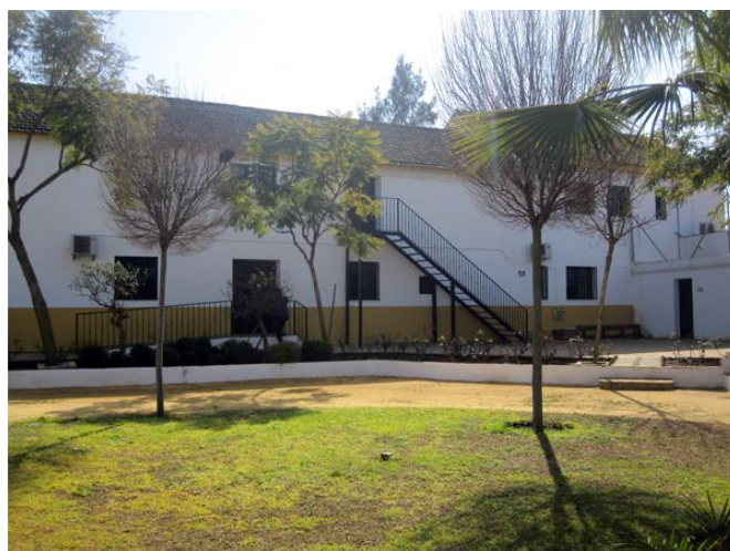
55. Fachada. Centro Cantalgallo.
