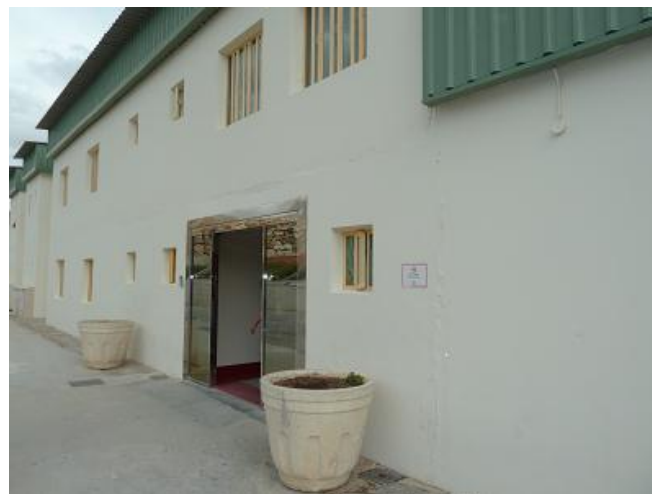
7. Fachada Edificio. Centro Purchena.
