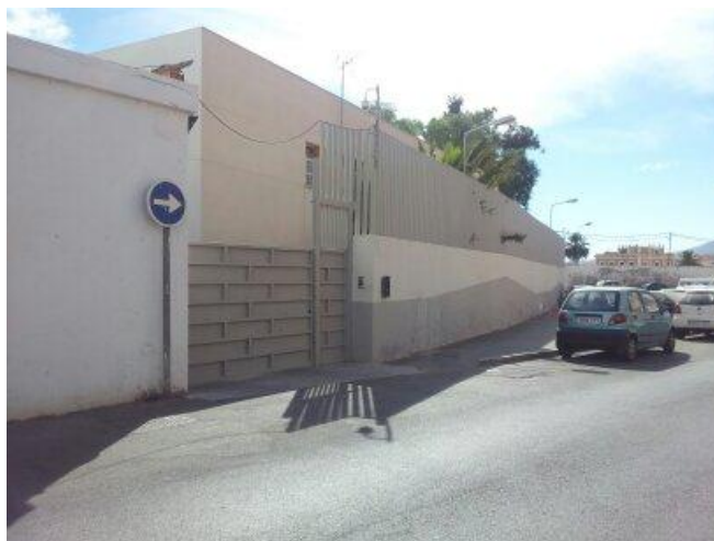
11. Exterior edificio. Centro El Molino.
