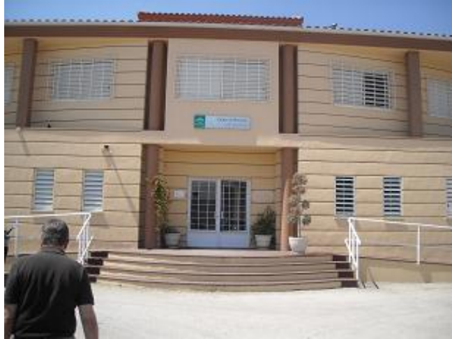
41. Entrada. Centro Las Lagunillas.
